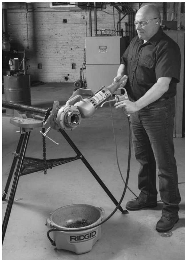
Figur 9 – Gevindskæring af rør
