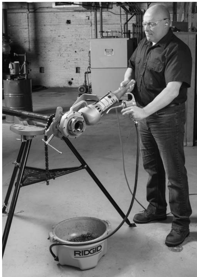
Figure 9 – Filetage des tuyaux
