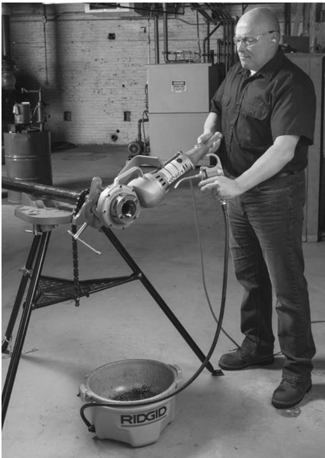
Abbildung 9 – Gewindeschneiden in Rohr
