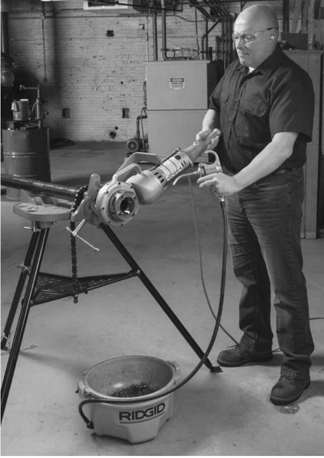
Şekil 9 – Boruya Diş Açılması
