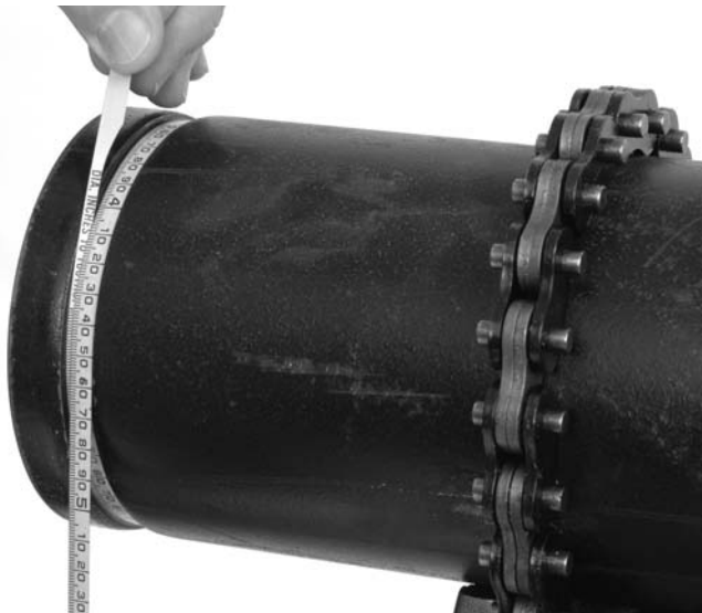
Figure 16 – Vérification du diamètre de rainure à l'aide d'un ruban à circonférence
