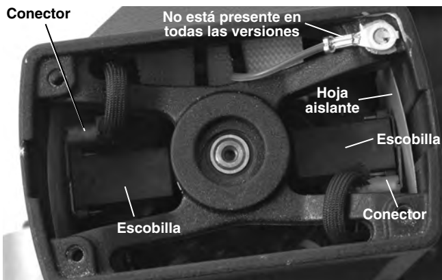
Figura 26 – Colocación de las escobillas, una vez retirada la tapa del motor
