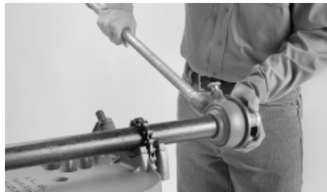
Figure 3 – Montage de la fileteuse sur le tuyau
