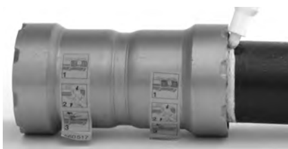
Figure 7 – Repérage du tuyau après son insertion
