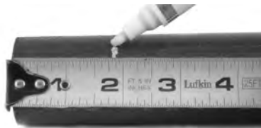
Figure 6A – Repérage de la profondeur d'insertion du tuyau à l'aide d'un mètre à ruban
