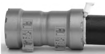
Figure 7 – Repérage du tuyau après son insertion
