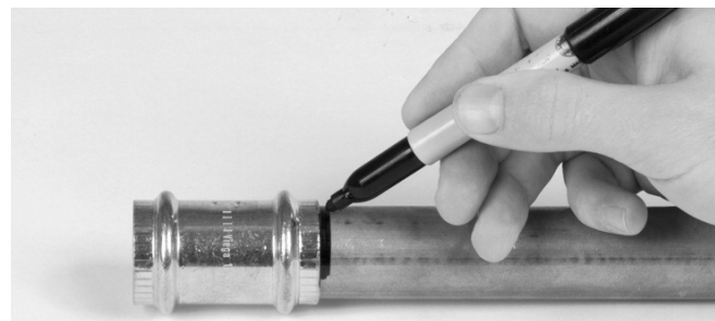
Figure 8 – Repérage du tuyau après insertion complète
