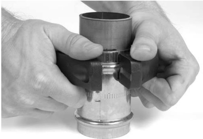
Figure 8 – Installation de la bague de sertissage sur le raccord
